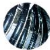
Linhas de transferência para gás liquefeito
